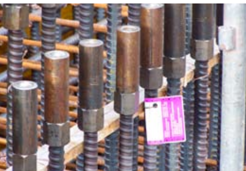
Halbmuffenstab, Typ HMS coupling bar, type HMS
