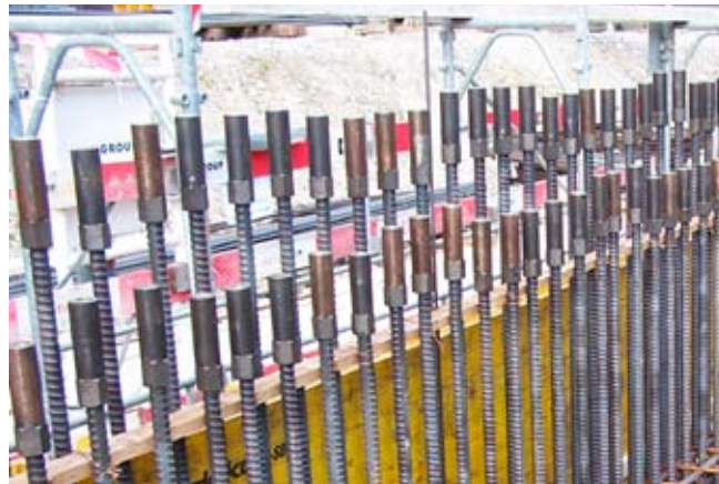
Halbmuffenstab, Schlaufe, Typ HMS coupling bar, type HMS
