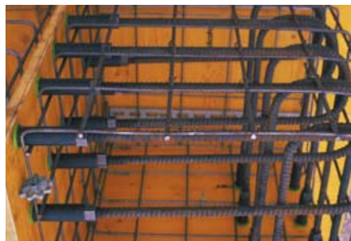
Halbmuffenstab, Schlaufe, Typ HMSS loop bar, type HMSS
