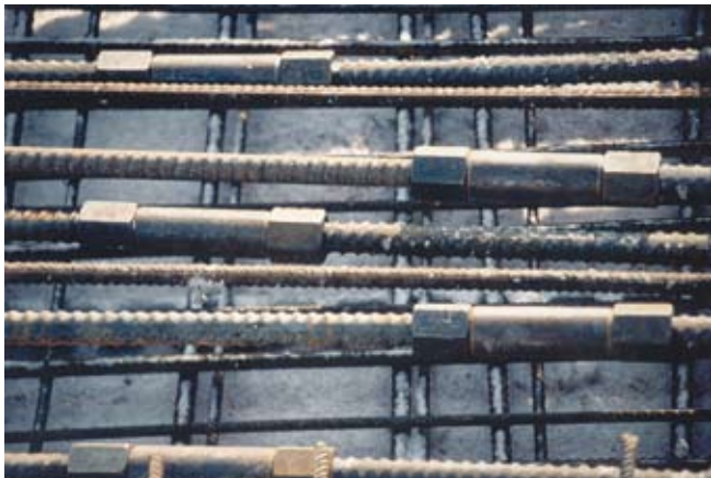
versetzte Muffenstöße staggered coupler connections
